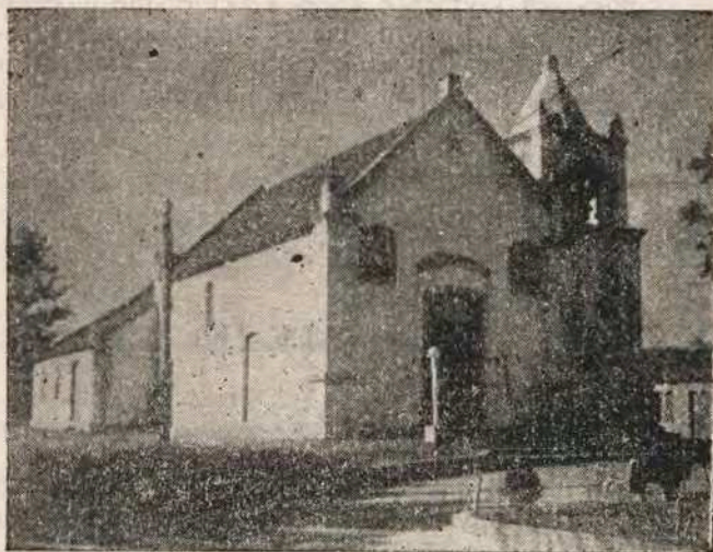
«A Igreja da Penha que acaba de ser demolida»
